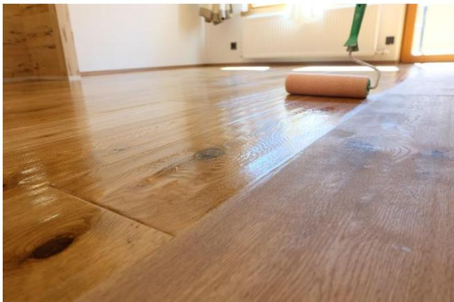
**Abb. 2** Ohne Beschichtung kann UV-Licht mit Holzoberflächen interagieren und zu Verfärbungen und Schäden führen.
