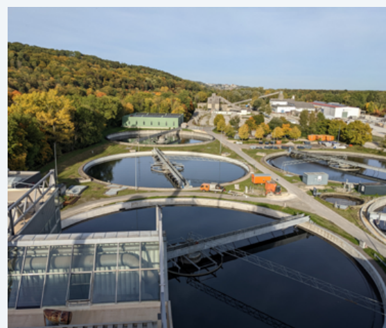
Klärbecken der Kläranlage Ulm-Steinhäule Foto: Marius Mohr / Fraunhofer IGB
