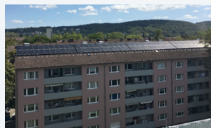
Ein Mehrfamiliengebäude im Smarten Quartier Karlsruhe-Durlach. Auf dem Dach wurde eine PV-Anlage mit 60 kWp Leistung installiert. Foto: Fraunhofer ISE
