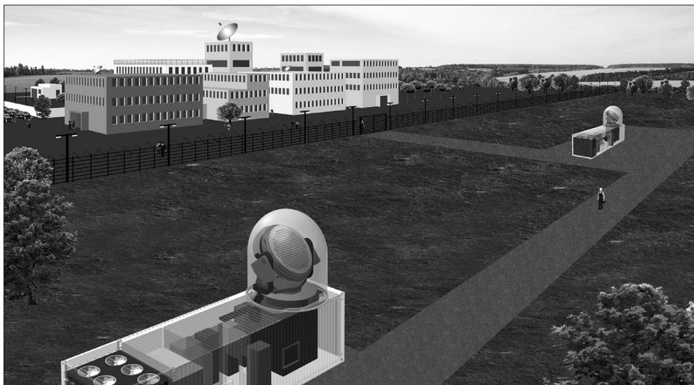
Sowohl die Sende- als auch die Empfangsantenne lassen sich vollständig einfahren. (© Fraunhofer FHR) | Bild in Farbe und Druckqualität: [www.fraunhofer.de/presse](http://www.fraunhofer.de/presse)
