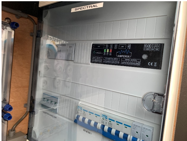
Abb. 3 Der Amperix® ist das Energiemanagementsystem des Fraunhofer ITWM, myPowerGrid eine Plattform für Microgrids und Energiecommunitys.
