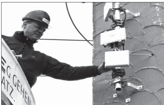
Ein Forscher richtet die Antennen der WiBACK-Anlage aus. (© Fraunhofer FOKUS)
