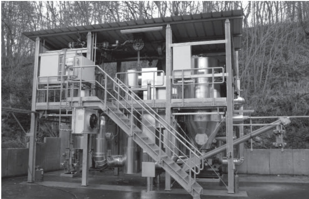
Pilotanlage zur energetischen Nutzung feinkörniger Produktionsreststoffe in Gerstungen. (© Fraunhofer IFF) | Bild in Farbe und Druckqualität: www.fraunhofer.de/presse
