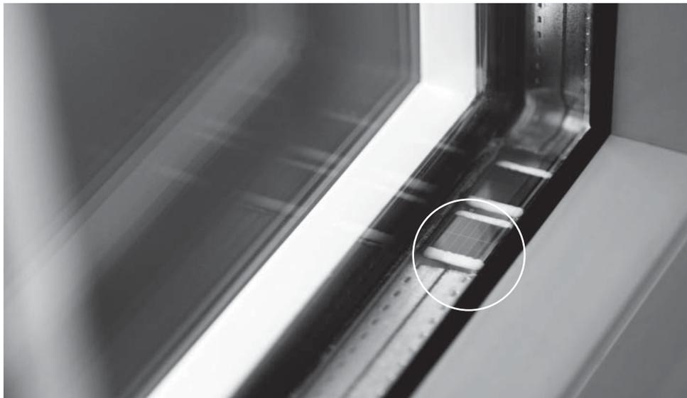
**Der im Fensterrahmen angebrachte Chip versorgt sich selbst mit Energie. (© Fraunhofer IMS) | Bild in Farbe und Druckqualität: [www.fraunhofer.de/presse](http://www.fraunhofer.de/presse)**
