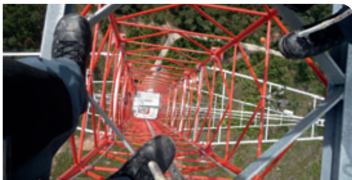
Spezialisten errichten den 200 Meter hohen Messmast. © Fraunhofer IWES
