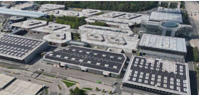
Auf den Dächern der Messehallen sind erste Photovoltaikanlagen installiert worden Foto: NürnbergMesse GmbH
