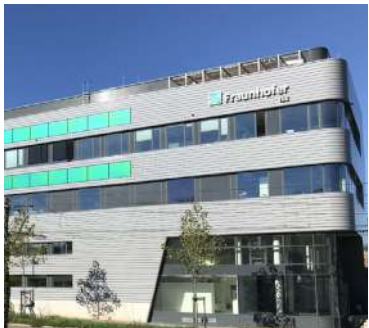
PV-Module mit grüner MorphoColor®-Strukturschicht an der Fassade des Fraunhofer ISE Foto: Fraunhofer ISE/ Benedikt Bläsi
